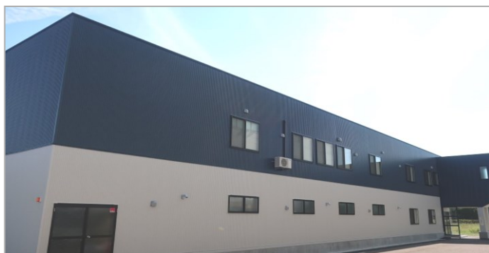
新潟工場 管理棟
